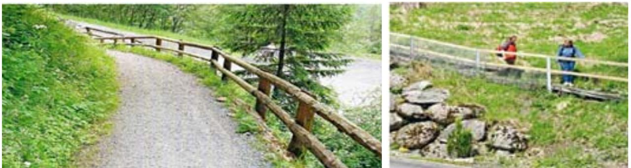
**Figura 2.2 - Esempi di barriere di contenimento con tecniche di ingegneria naturalistica**
