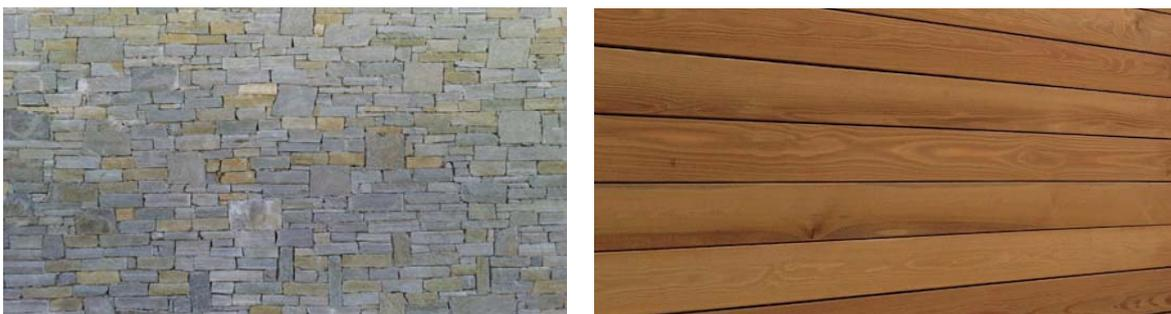
**Figura 2.8 – Rivestimenti in pietra locale e doghe di larice orizzontali che verranno utilizzati per le coperture della stazione intermedia**
