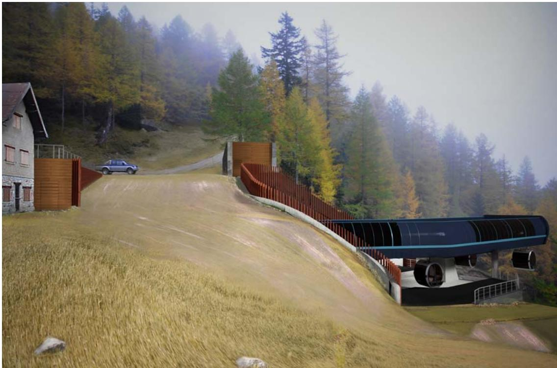
**Figura 2.7 - Rendering della stazione intermedia interrata, l'impatto visivo dell'opera è mitigato dal passaggio della pista**
